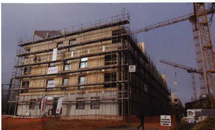
▲ R + 3 + combles, l'immeuble abritera 140 logements de type PLUS, PLAI et PLS.
