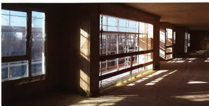
▲ Un étage en structure bois représente trois camions de murs CLT, neuf camions de planchers, un camion de charpente lamellée-collée et 6 jours de pose.
