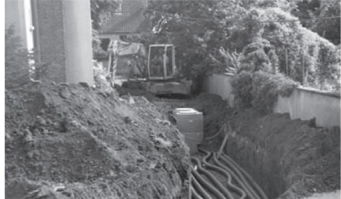
Fig. 19. Implantation des canalisations avant terrassement (source : Canada Clim)
